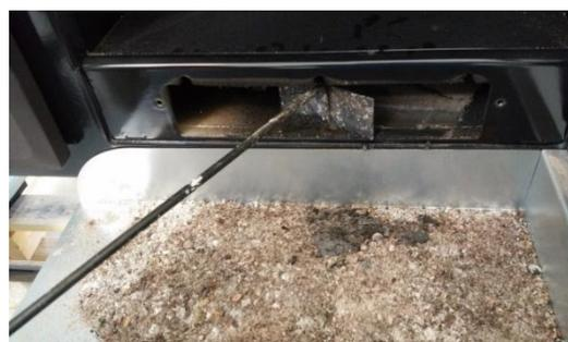
Abbildung Nr.18 - Zugänge zum Reinigen des Rauchabzugs.
