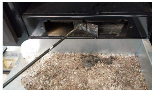
Figura nº21 - Accesos para la limpieza de la salida de humos.
