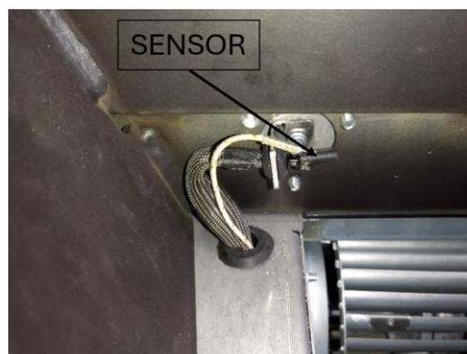
Figure n°24 - Position de la sonde de température (SENSOR) dans la sortie d'air chaud
